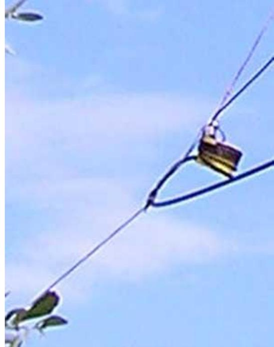
Empalmado el coaxial de  $75\Omega$  al de  $50$  in situ, con dos vueltas añadidas de RG213, que a su salida del chofe formado, DEBE de ser amarrado a la cuerda tensora del vértice inferior para evitar problemas de tirones, tanto en el montaje, como por los provocados por el viento.
